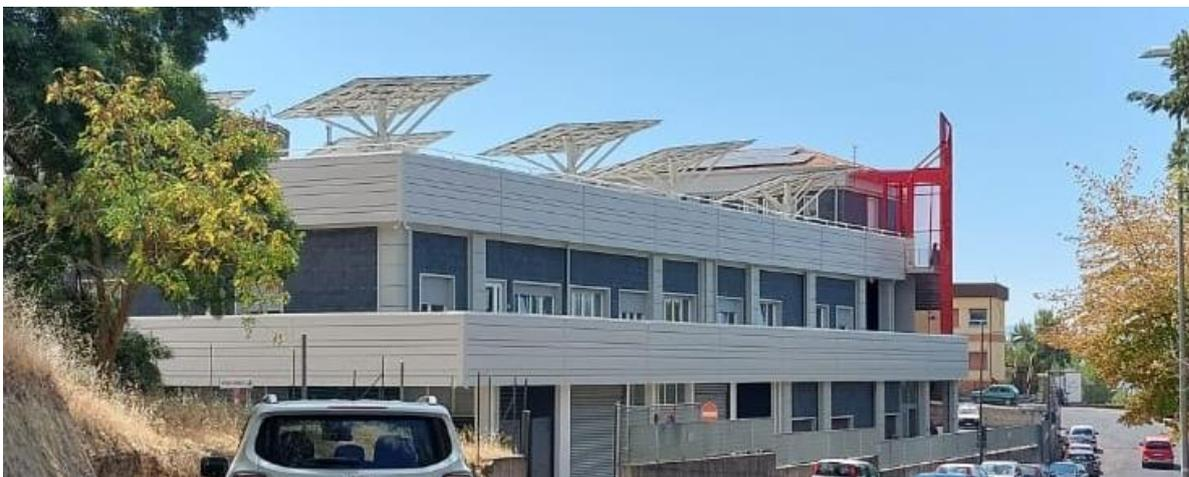
**Scuola San Michele** - Isolamento esterno a cappotto, sostituzione degli infissi esistenti con infissi in PVC a taglio termico, impianto fotovoltaico da Kw 30, impianto di raffrescamento e riscaldamento a pompa di calore;
